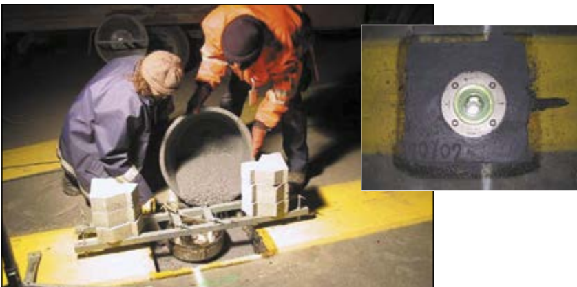
Flughafen in Nordrhein-Westfalen: Austausch und Einbau von Unterflurleuchtfeuern in der Nacht ohne Unterbrechung des Flugverkehrs
