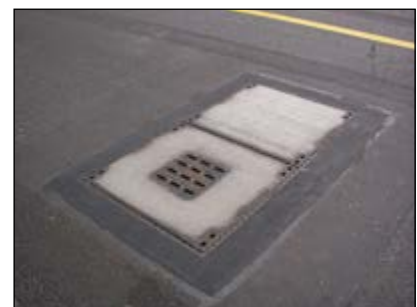
Flughafen in Nordrhein-Westfalen: Verguss von Kabelschächten mit SILIKAL® Mörtel R 17 in Asphaltfarbe
