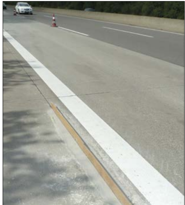
Autobahn A4 bei Düren/Weisweiler: Kantensanierung der Betonfahrbahn
