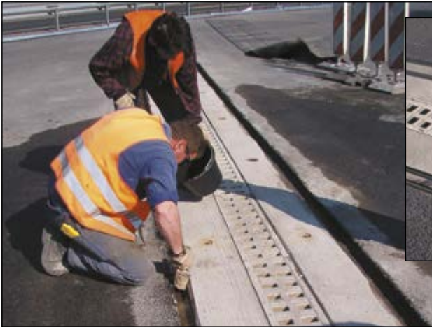
Autobahn A2 bei Hamm-Uentrop: Einbau der Entwässerungsquerrinnen
