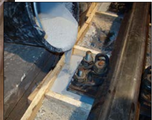
Deutsche Bahn AG, Betriebswerk Braunschweig: Sanierung von Schienenlagern
