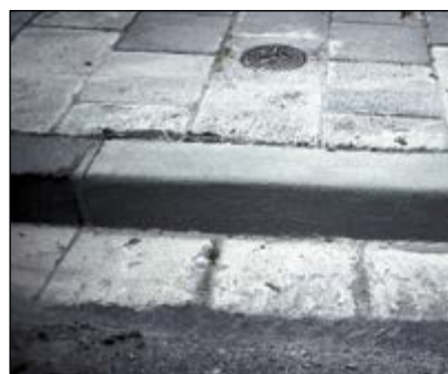
Sanierung von Bordsteinen mit SILIKAL® Mörtel R 17
