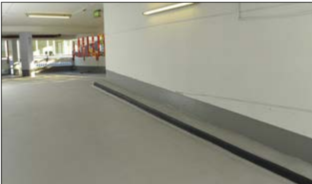
Koblenz, Parkhaus „Altlöhrtor“: Sanierung der Zu- und Abfahrtsrampen
