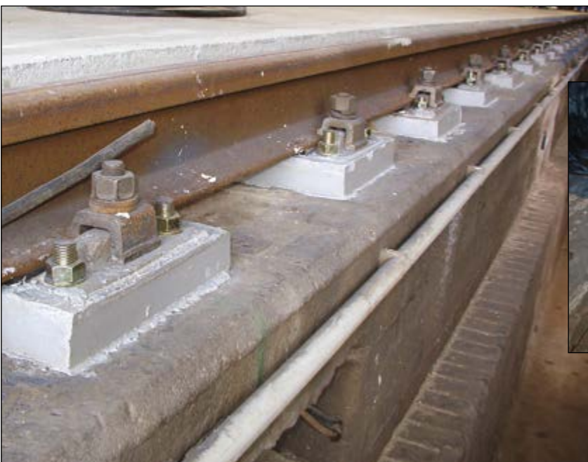
Deutsche Bahn AG, Betriebswerk Braunschweig: Sanierung von Schienenlagern
