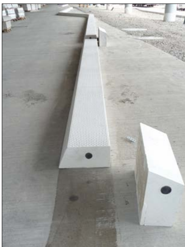
Stuttgart, Parkhaus Flughafen: Bordsteinverklebung mit SILIKAL® Mörtel R 17 thix auf Beton
