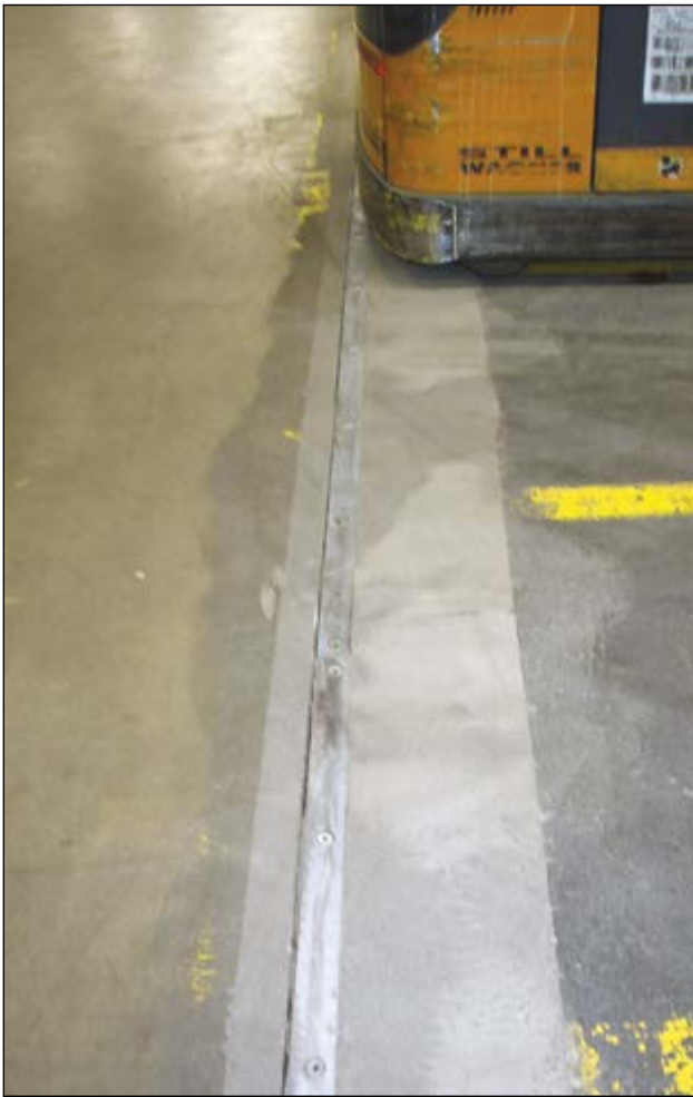
Metro AG, Essen: Sanierung von Dehnungsfugen in einer Lagerhalle
