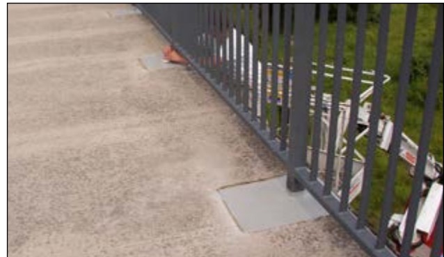
Autobahn A11: Brückenkappensanierung
