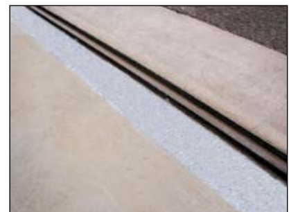
Flughafen Mannheim: Verguss von Rolltorschienen
