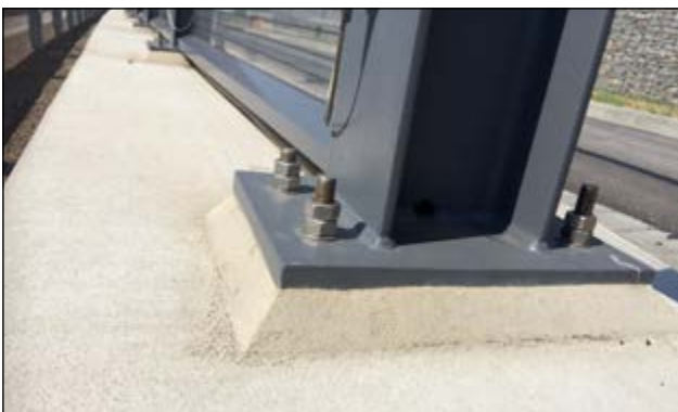
Bundesstraße B42: Unterstopfung von Lärmschutz-Fußplattenpfosten
