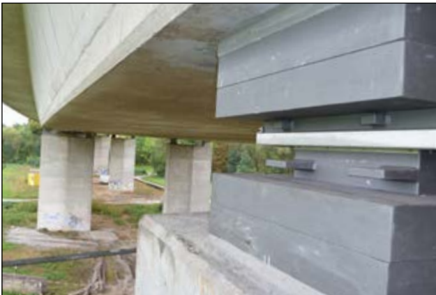
Autobahnbrücke A6, Maßholdertal: Sanierung der Brückenlager
