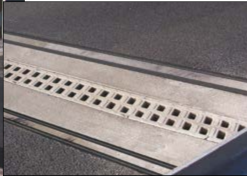
Autobahn A2 bei Hamm-Uentrop: Einbau der Entwässerungsquerrinnen
