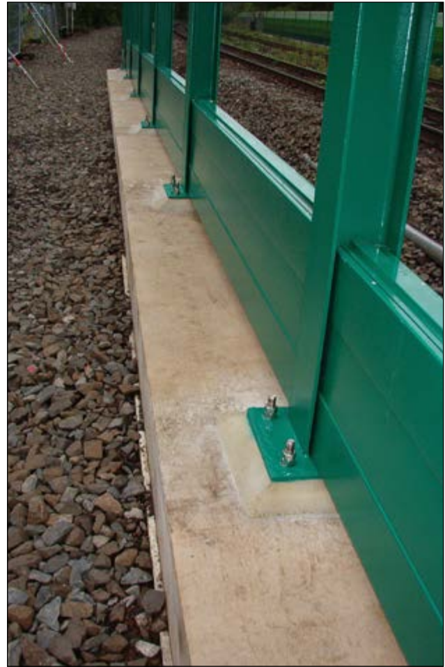
Bahnstrecke Koblenz-Bonn: Unterstopfung von Lärmschutz-Wandpfosten
