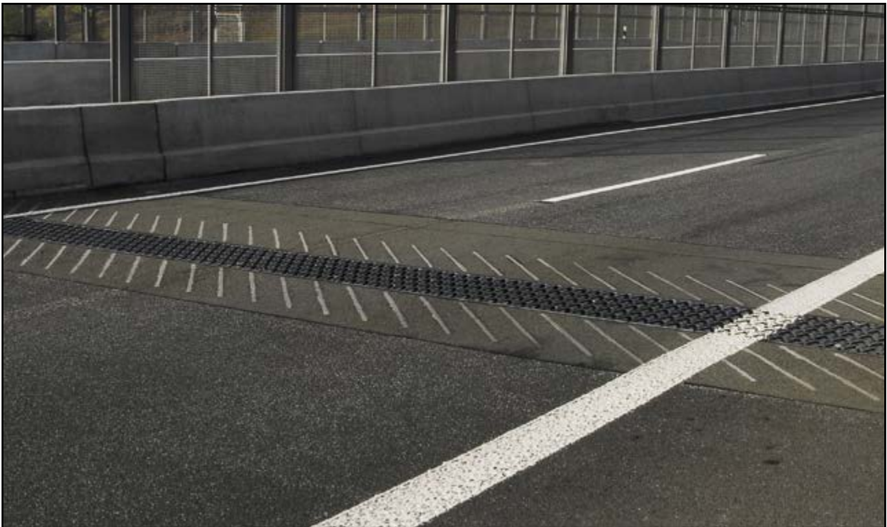
Autobahn A38 bei Breitenworbis: Stützrippenverguss
