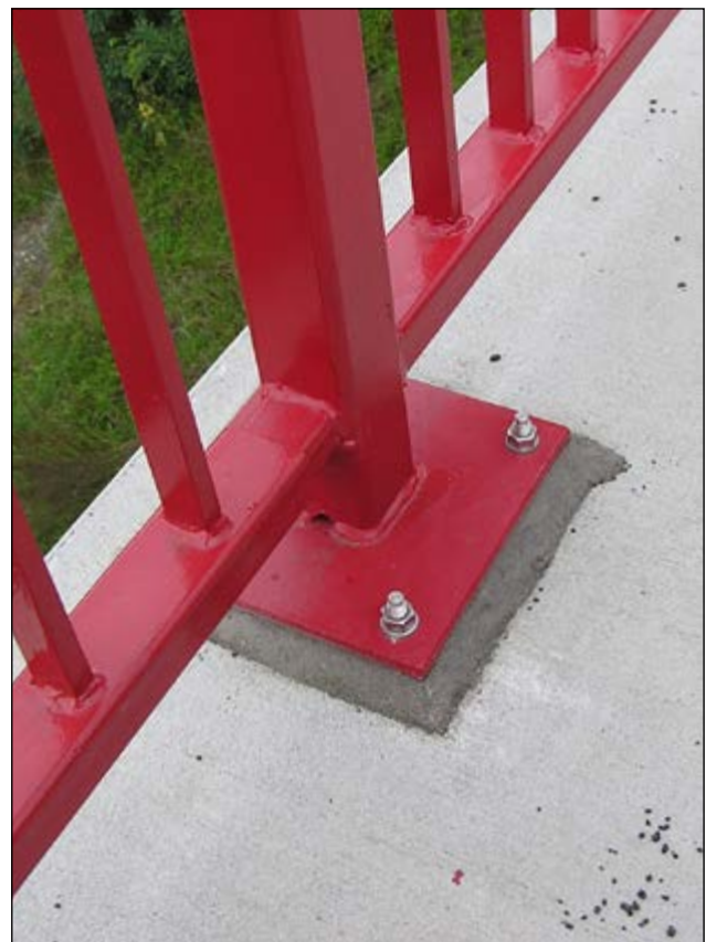
Rheinbrücke Wessel: Unterstopfung von Geländerpfosten
