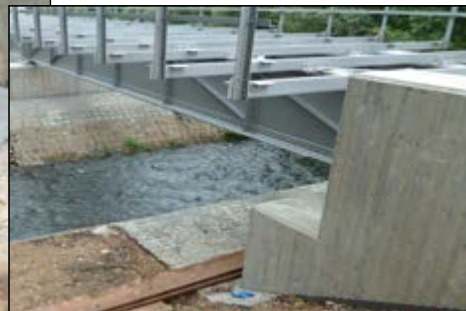
Neubau der Eisenbahnbrücke Grafenwöhr: Verguss von Brückenlagern
