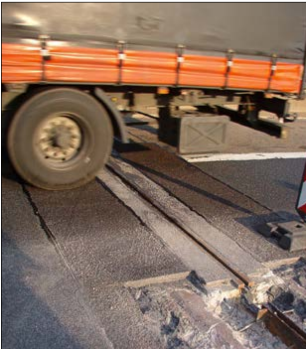
Autobahn A45 bei Solms: Sanierung der ÜKO-Stützbalken
