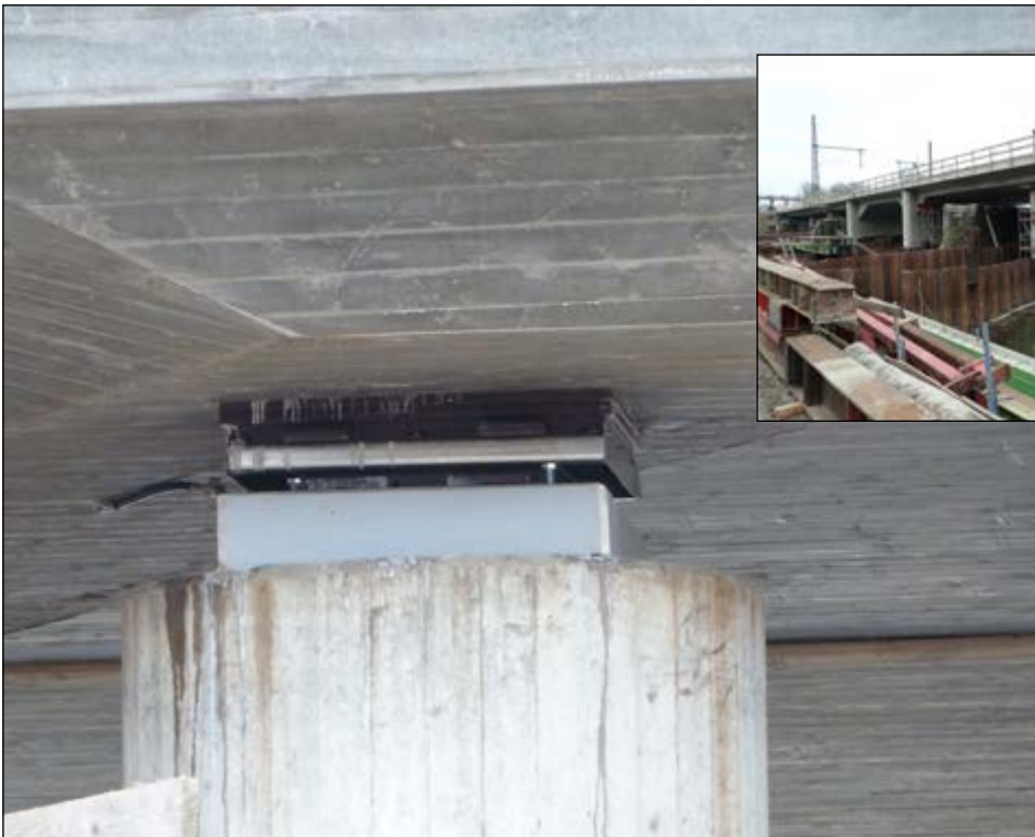
Neubau der Eisenbahnbrücke Hannover-Ohedamm: Lagerverguss
