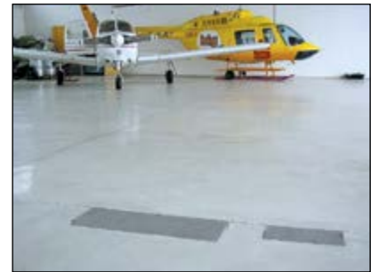
Flughafen Mannheim: Bodensanierung Flugzeughangar
