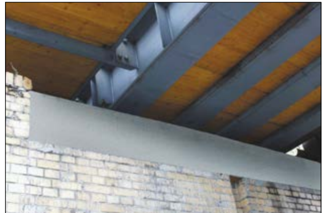
S-Bahnbrücke, Berlin, Sterndamm: Sanierung des Brückenwiderlagers
