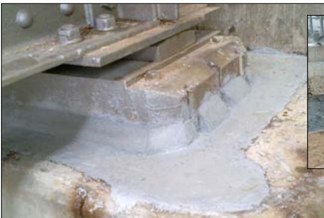
Autobahnbrücke A6, Maßholdertal: Sanierung der Brückenlager
