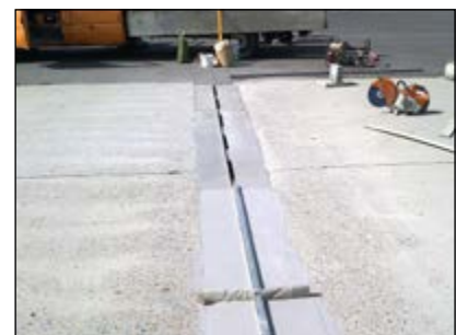
Nato-Airbase Geilenkirchen: Rinnensanierung
