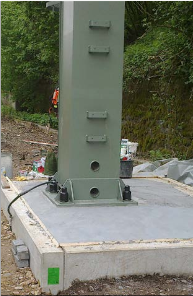
Bahnstrecke Düsseldorf-Wuppertal: Verguss von Signalmasten
