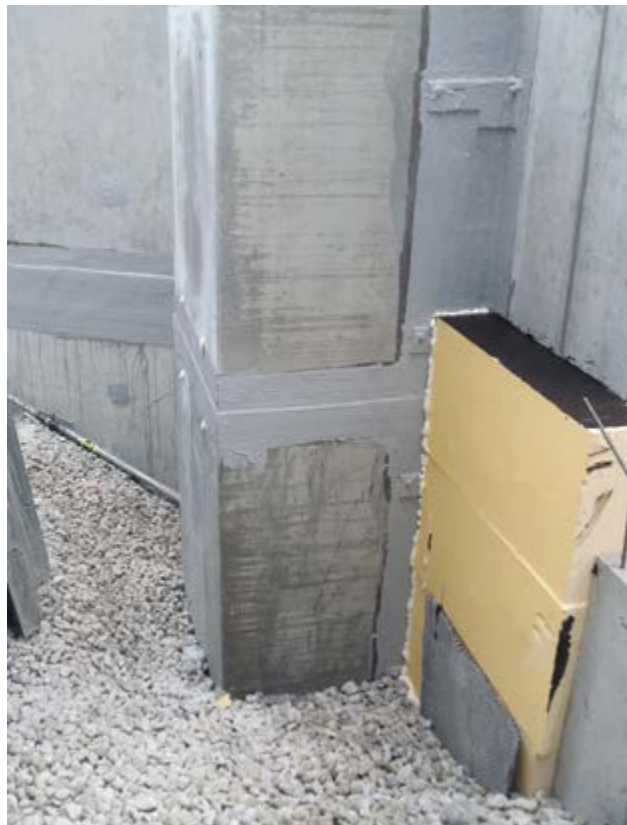
Abdichtung von Betonarbeitsfugen
