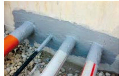
Bauteilanschluss/Flächenabdichtung
