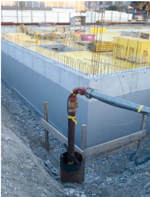
Flächenabdichtung im Unterterrainbereich
