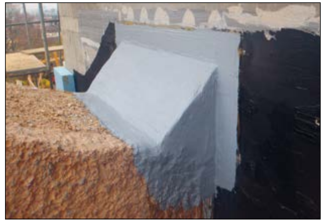
Bauteilanschluss/Flächenabdichtung
