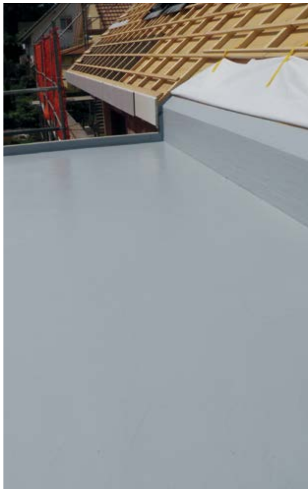
Bilder oben: Balkon- und Dachabdichtungen
