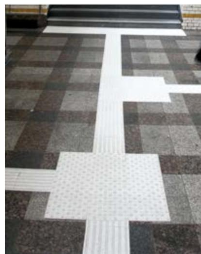
**Silikal **TAC-WAYflex** Bodenindikatoren lassen sich einfach, schnell und dauerhaft mit Hilfe des MMA-Systems Silikal R 90 verkleben**
