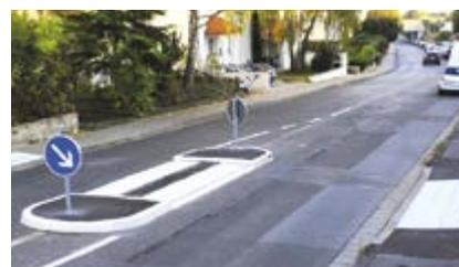
Silikal **TAC-WAYflex** Bodenindikatoren entstehen auf Basis werksgefertigter Kaltplastikplatten. Sie sind an ihren schmalsten Stellen nur zwei Millimeter dünn und passen sich leichten Unebenheiten im Untergrund flexibel an. Vier Millimeter hohe Rippen beziehungsweise Noppen übernehmen die Leitfunktion. Sie weisen die Richtung, geben Orientierung und warnen an kritischen Stellen.
