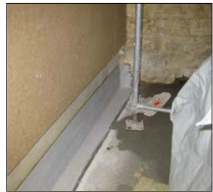
Materialwechsel-/Fugenabdichtung
