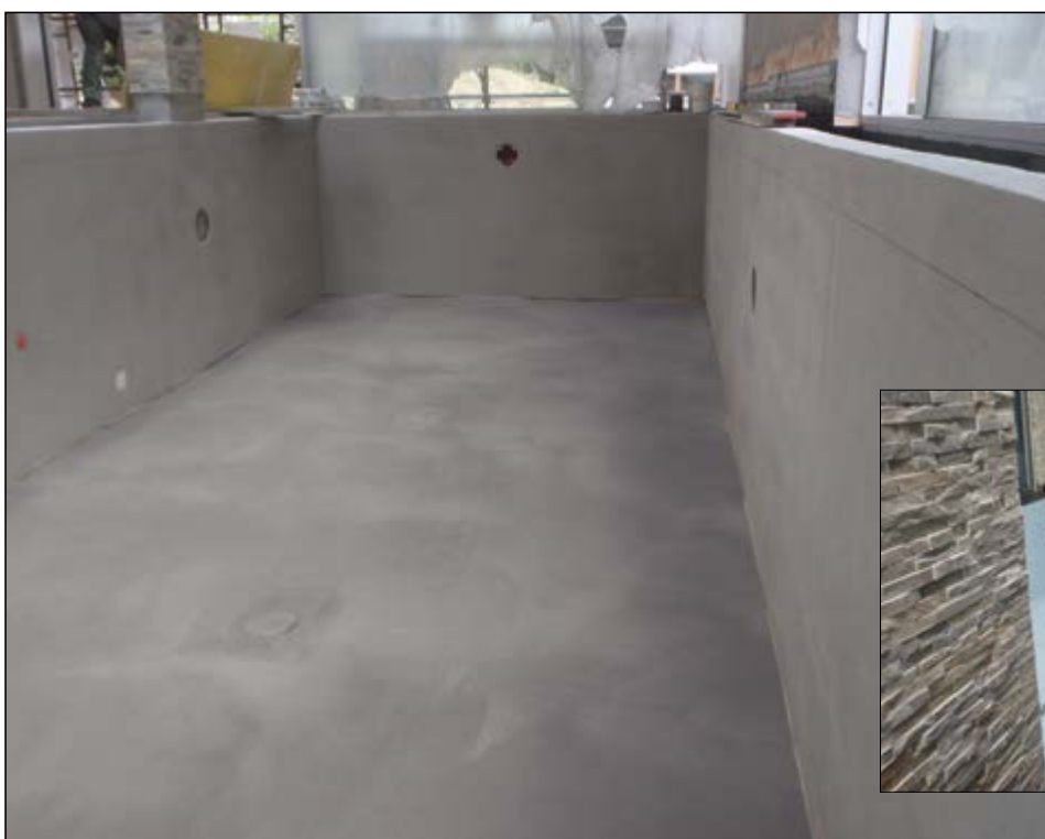
Schwimmbadabdichtung mit anschließender Ver- fliesung
