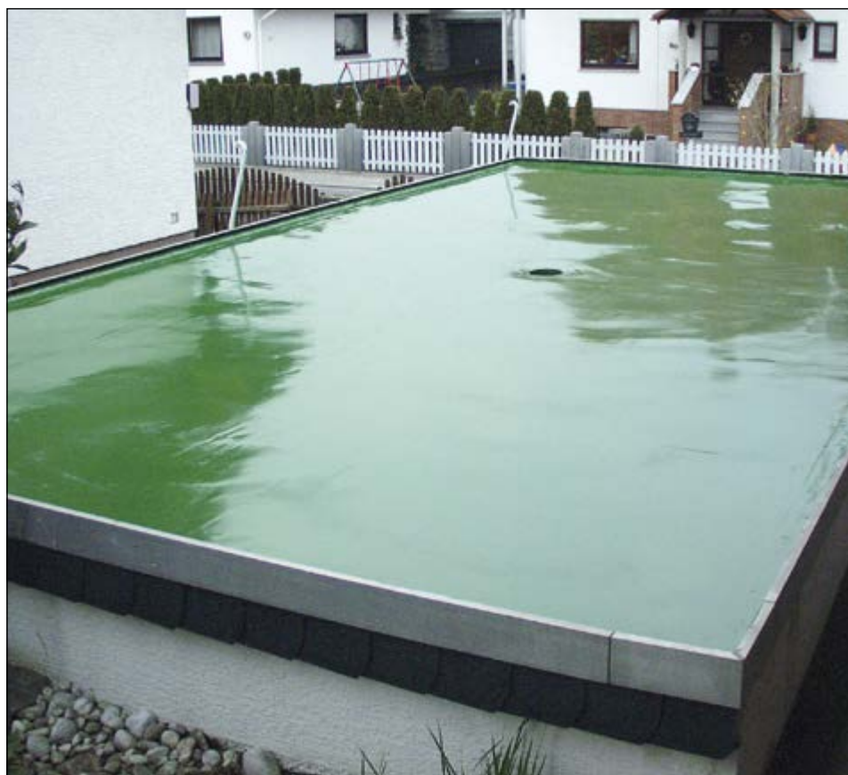
Flachdachabdichtung einer Doppelgarage
