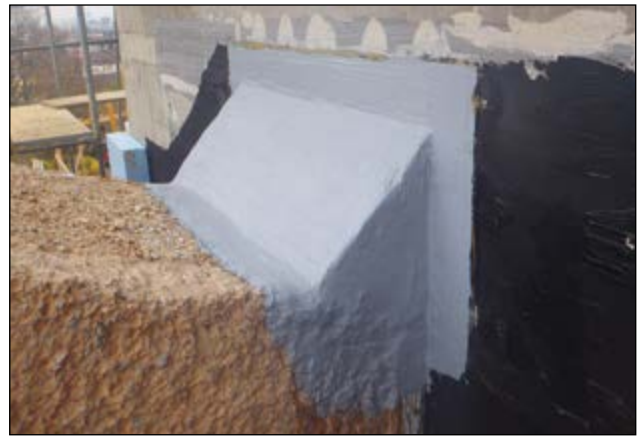
Bauteilanschluss/Flächenabdichtung
