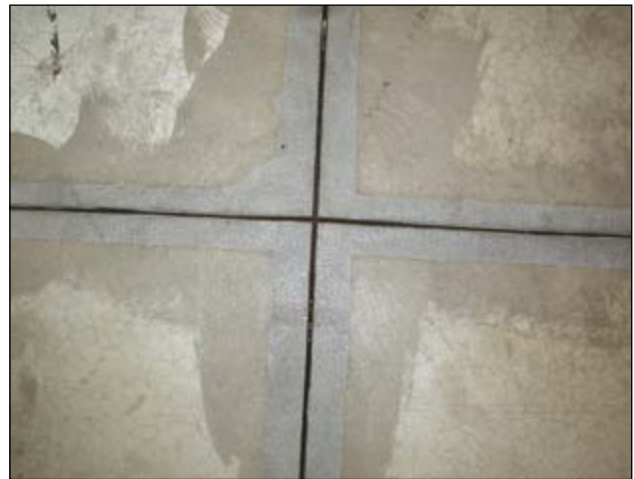
May Werke GmbH & Co. KG, Erfstadt-Köttingen: Renovation of expansion joints
