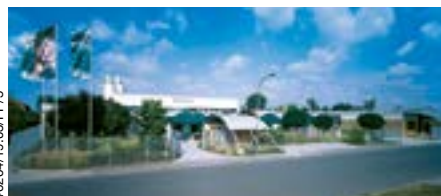
Silikal, Produktion und Verwaltung in Mainhausen / Silikal production and administration in Mainhausen, Germany.
