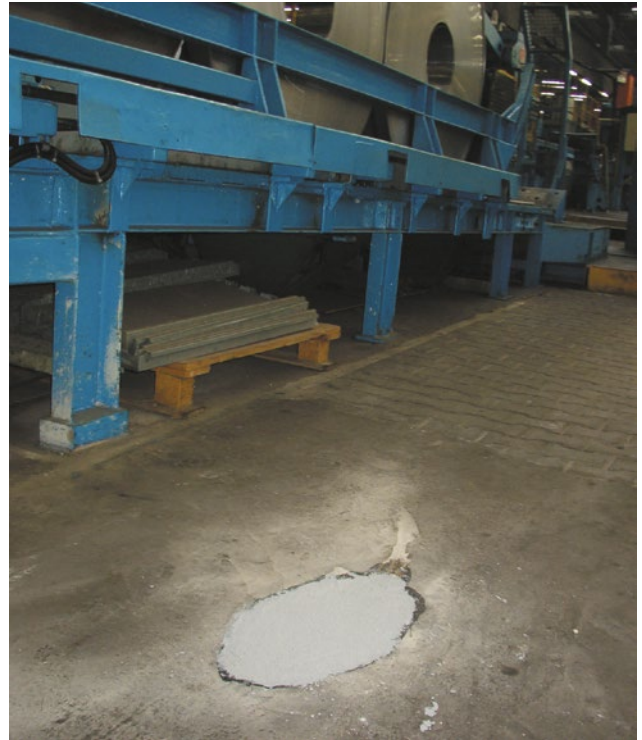
Top: MHP Mannesmann Präzisionsrohr GmbH, Hamm/Germany: Repairing pot holes
