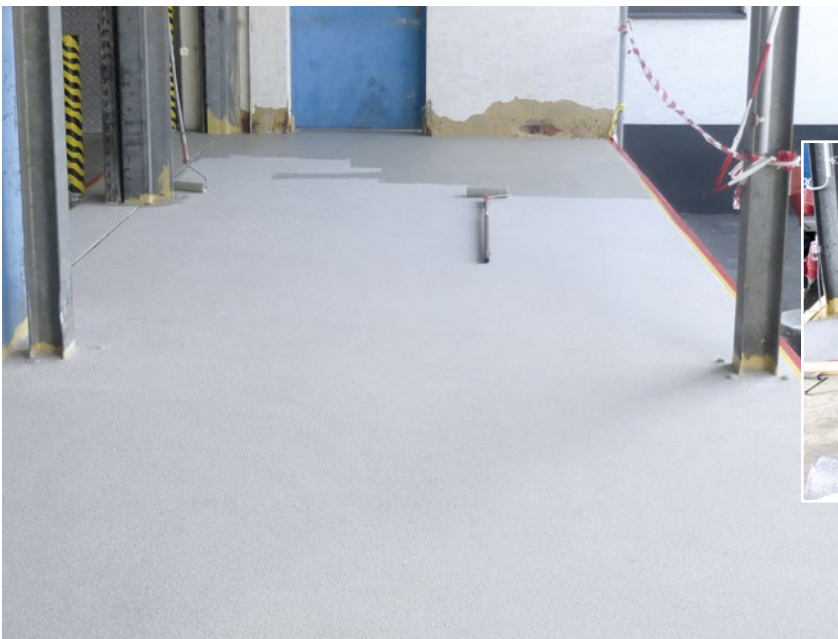
Left: Fahrzeugwerke Faymonville AG, Billingen/Belgium: Repairing expansion joints
