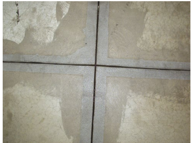
May Werke GmbH & Co. KG, Erftstadt-Köttingen/Germany: Renovation of expansion joints
