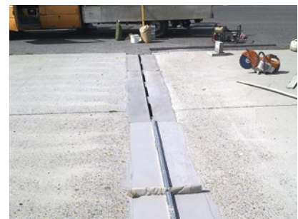
Nato Airbase Geilenkirchen/Germany: Gutter renovation
